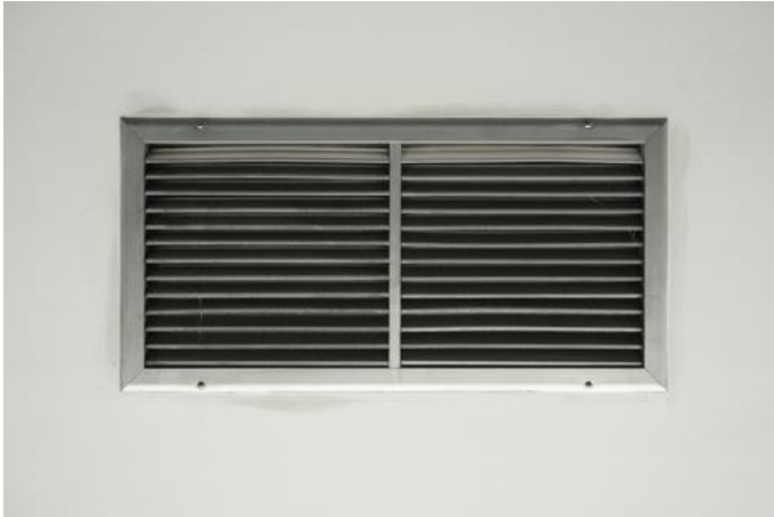
SLIKA 18: ZRAČNIKI PRI TOPLOZRAČNEM OGREVANJU. VIR: HTTP://WWW.SLONEP.NET/ZAKLJUCNA-DELA/OGREVANJE-IN-KLIMATIZACIJA/VODIC/TOPLOZRACNO-OGREVANJE
